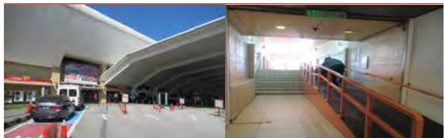
Kedudukan parkir OKU yang bahaya, di laluan utama keluar masuk kenderaan & laluan ramp yang curam menyukarkan pergerakan OKU berkerusi roda
